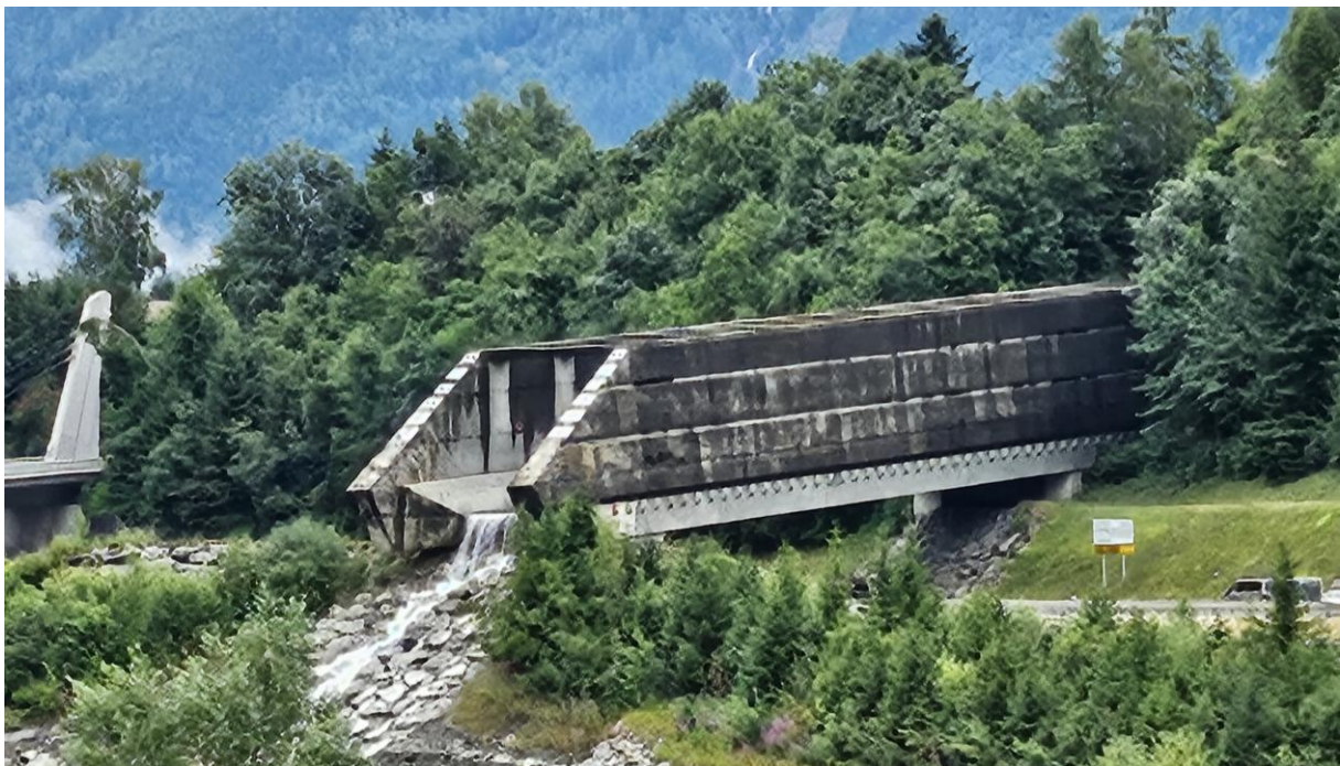
Pont-rivière de la route nationale 205 au niveau des Houches. © D. Decrouez
